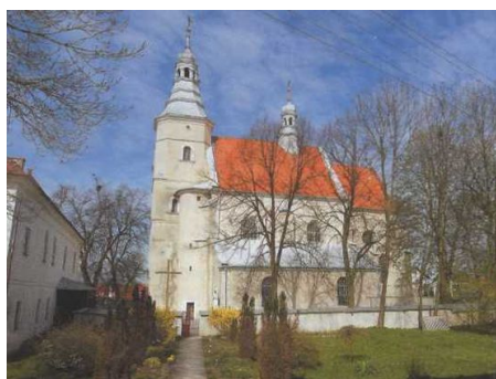
Kościół pw. WNMP w Koniemłotach od strony południowej.
