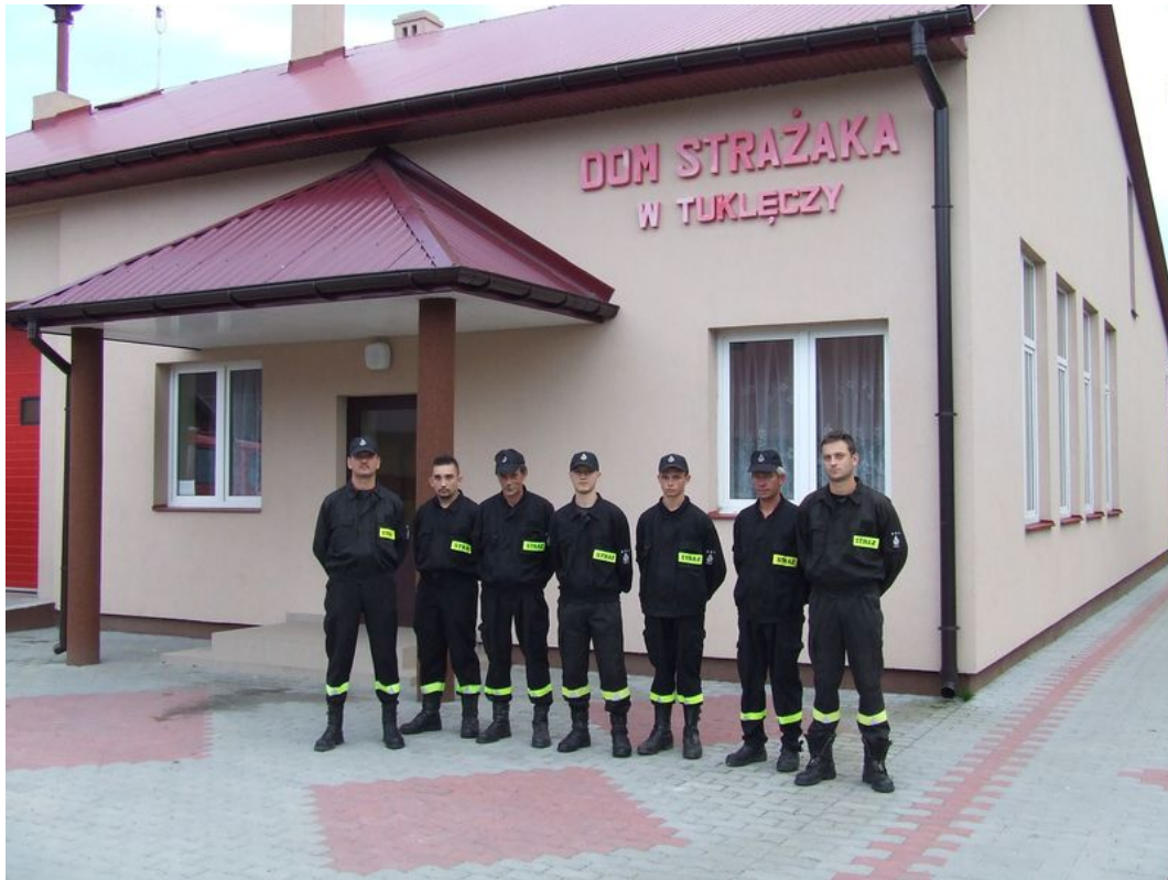
Druhowie z jednostki przed wyremontowaną strażnicą
