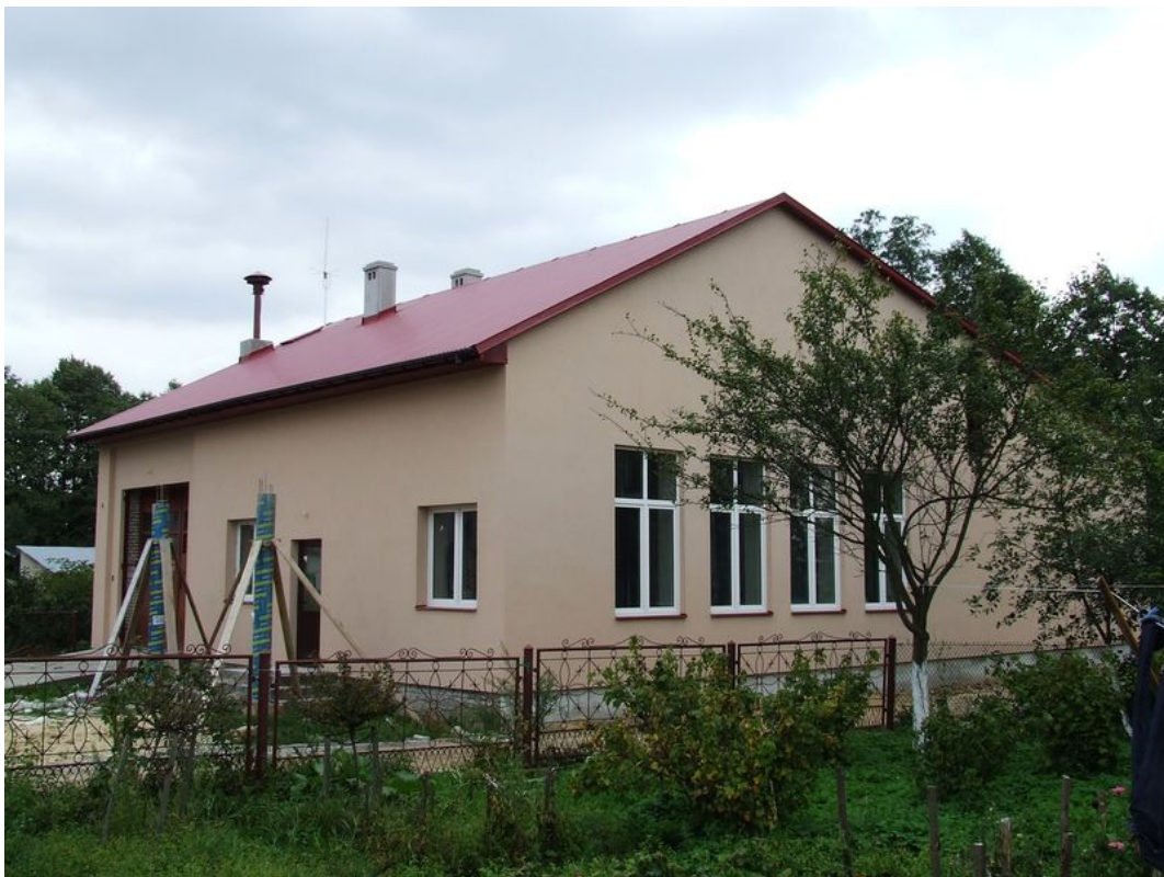
Strażnica podczas rozbudowy i remontu w latach 2006-2007.
