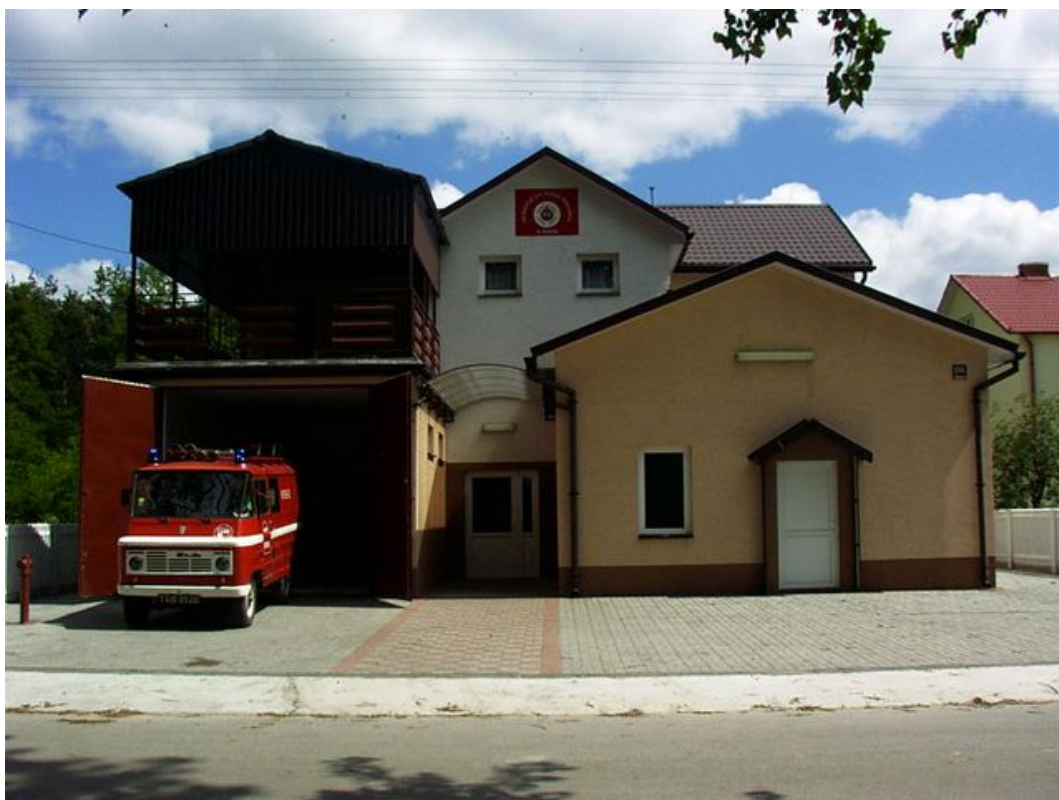
Strażnica w Rudzie po rozbudowie zakończonej w 2003 roku.
