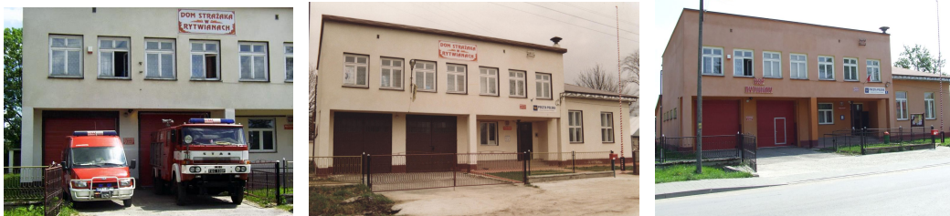
Elewacja budynku przed (foto 1,2) i po remoncie (foto 3)
