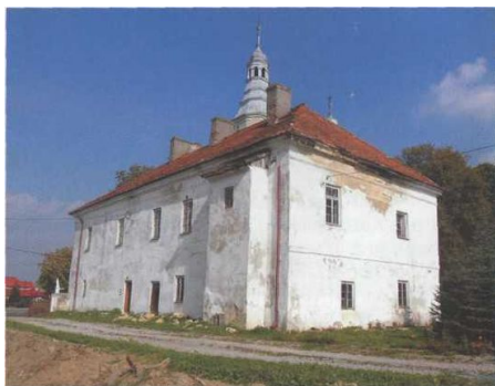
Budynek poklasztorny (stara plebania).
