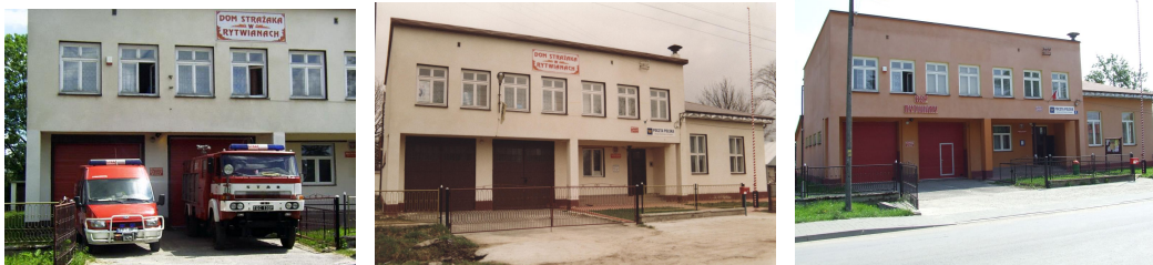
Elewacja budynku przed (foto 1,2) i po remoncie (foto 3)
