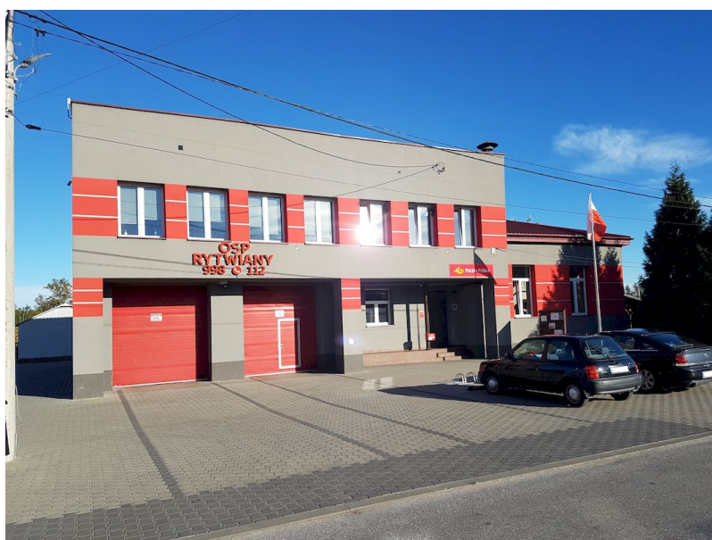
Strażnica OSP Rytwiany po wykonaniu prac modernizacyjnych
