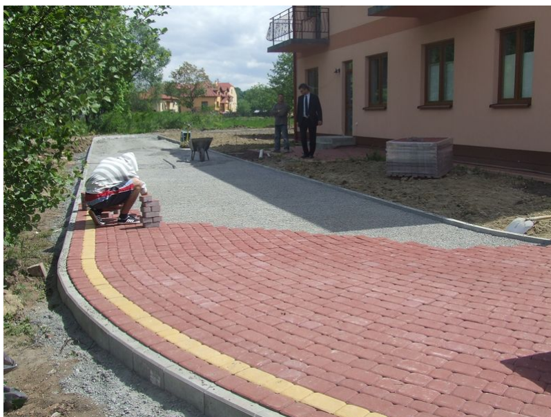
Układanie kostki brukowej, betonowej na ciągu pieszym wokół kościoła
