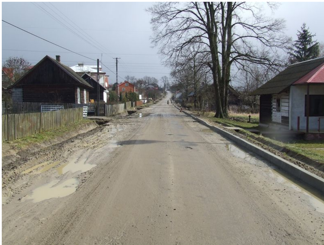
Remontowana droga w Szczecze po wykonaniu krawężnika
