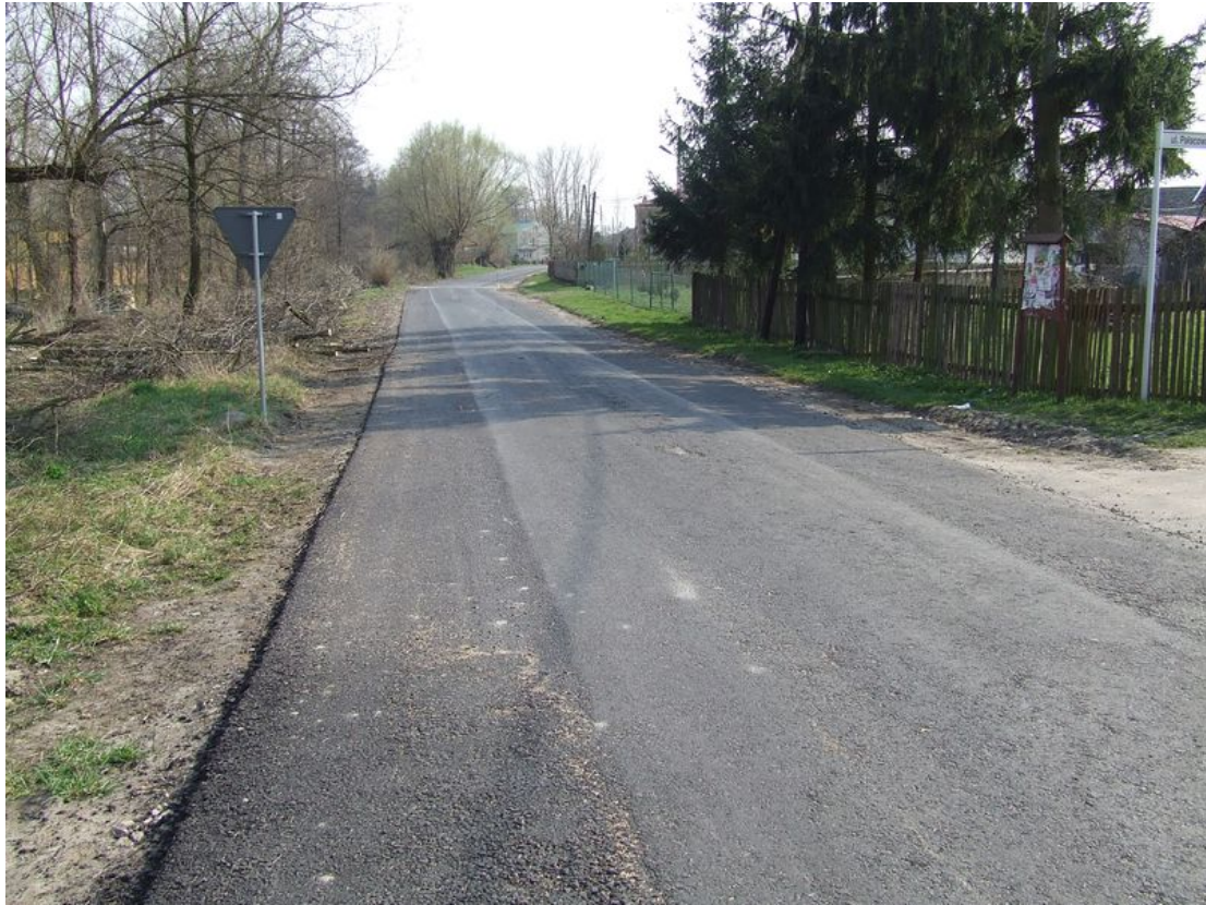
Ulica Niwy po położeniu pierwszej warstwy asfaltu.
