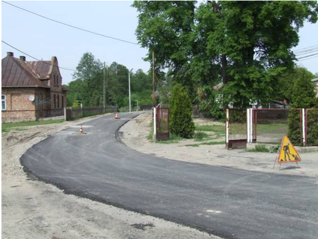
Ulica Kościuszki w Rytwianach w trakcie remontu.
