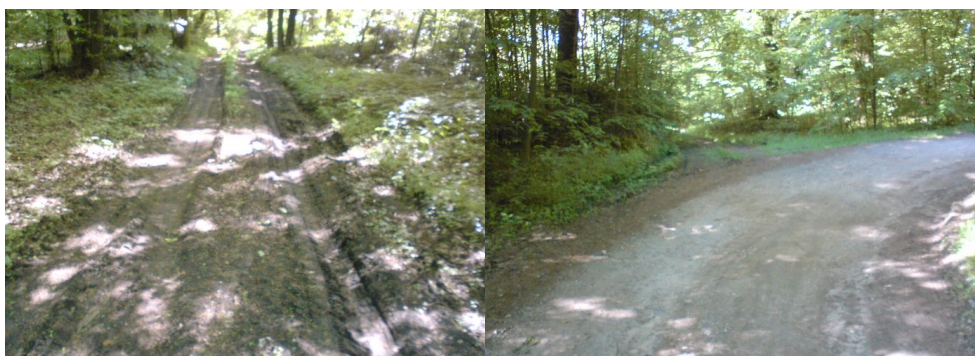
Fragment ulicy Kamedulskiej, który zostanie gruntownie przebudowany.
