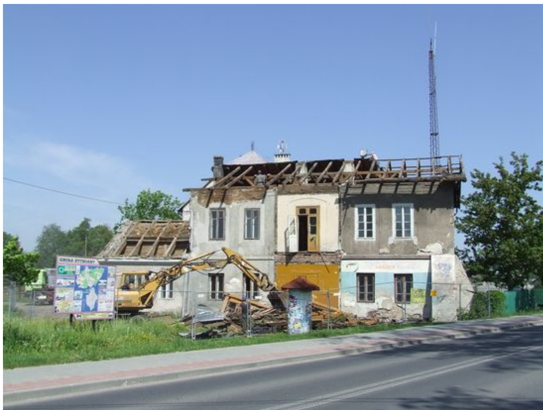
Prace rozbiórkowe starego Urzędu Gminy.
