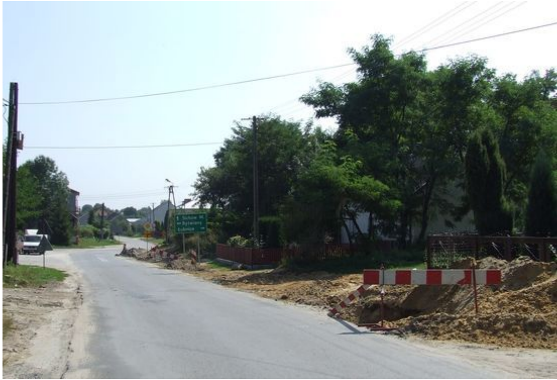
Odcinki drogi w Sichowie Dużym oraz Sichowie Małym
