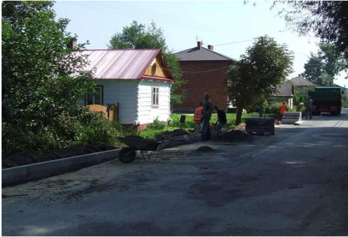
Remont drogi w Strzegomiu.
