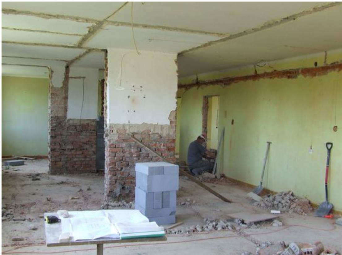
Prace wewnątrz budynku
