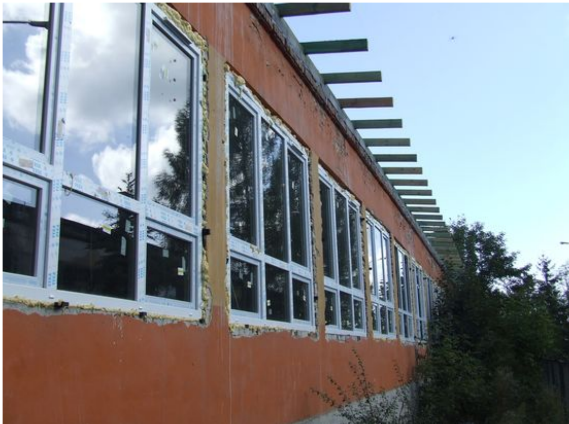
Nowa stolarka okienna na budynku sali widowiskowej
