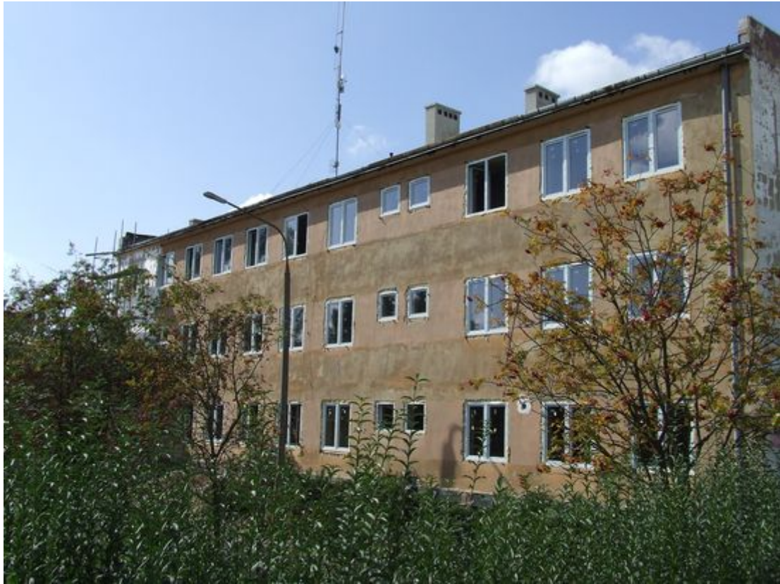
Wymieniona stolarka okienna, rozpoczęte prace docieplania budynku
