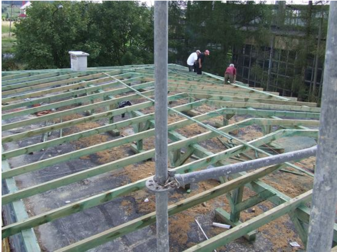
Budowa konstrukcji dachu nad salą widowiskową
