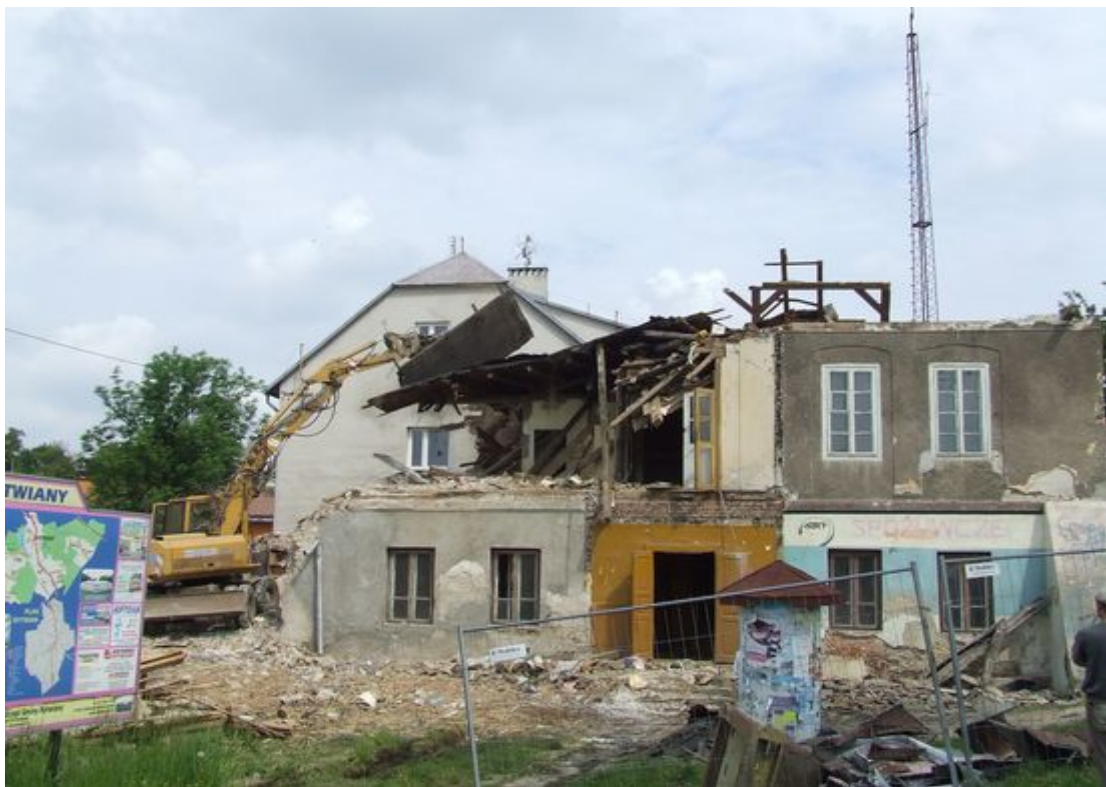
Rozbiórka starego budynku Urzędu Gminy
