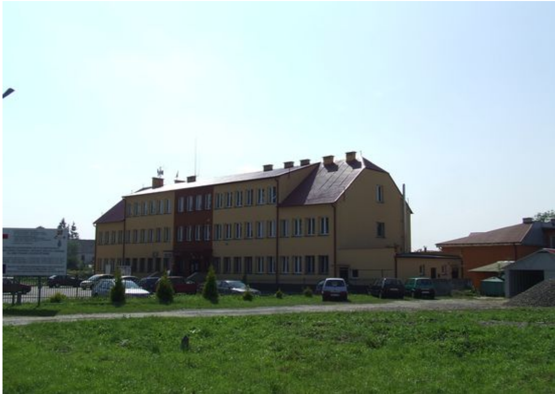
Nowa elewacja na budynku Urzędu Gminy
