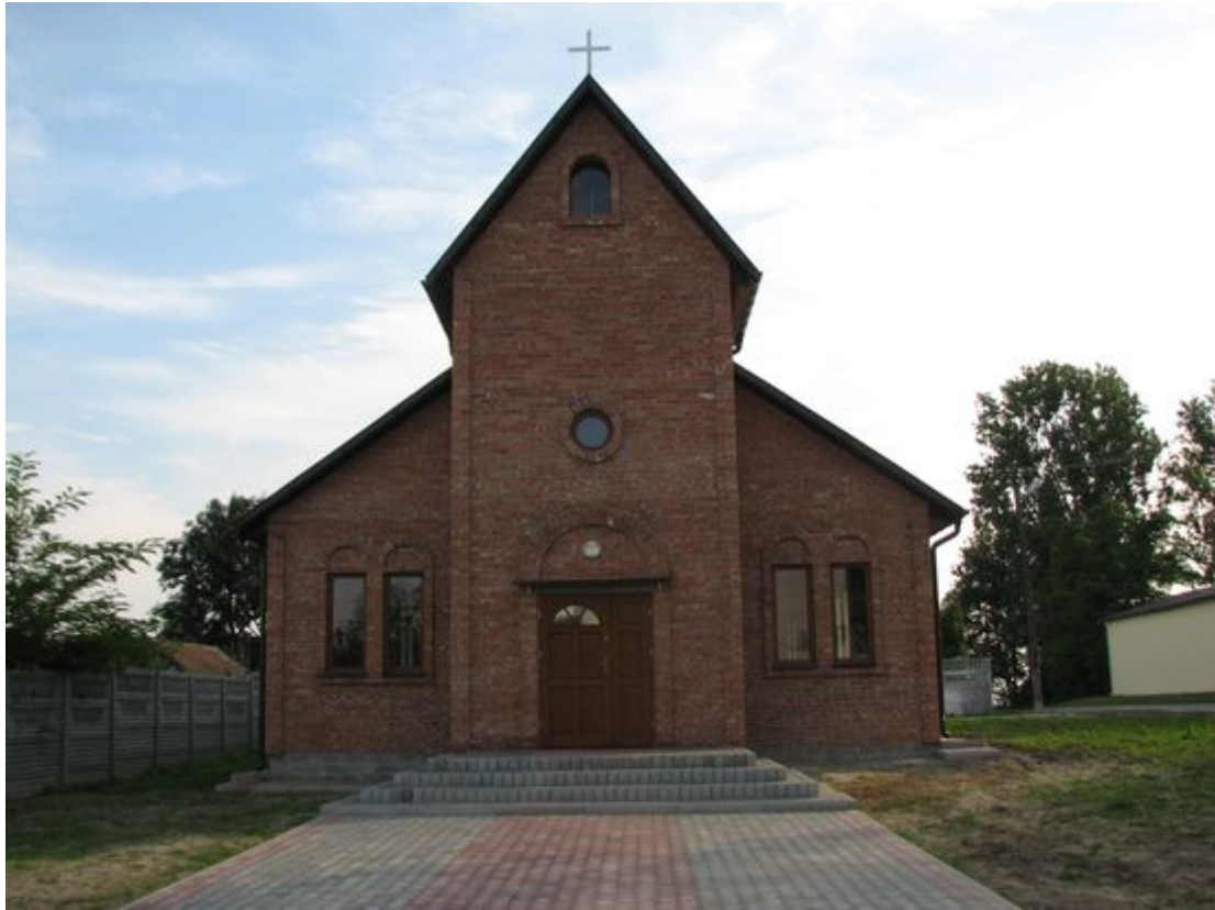
Wejście główne do nowej Kaplicy.
