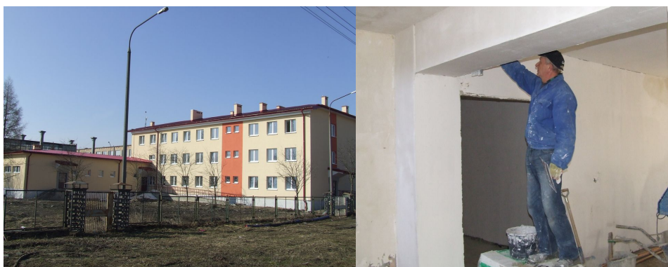
Gminny Ośrodek Kultury w Rytwianach, prace wewnątrz (po prawej)
