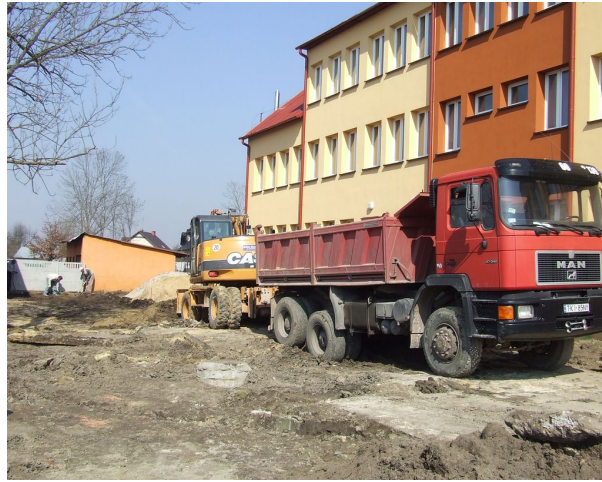
Pracownicy wykonujący przyłącze kanalizacyjne do budynku Urzędu Gminy
