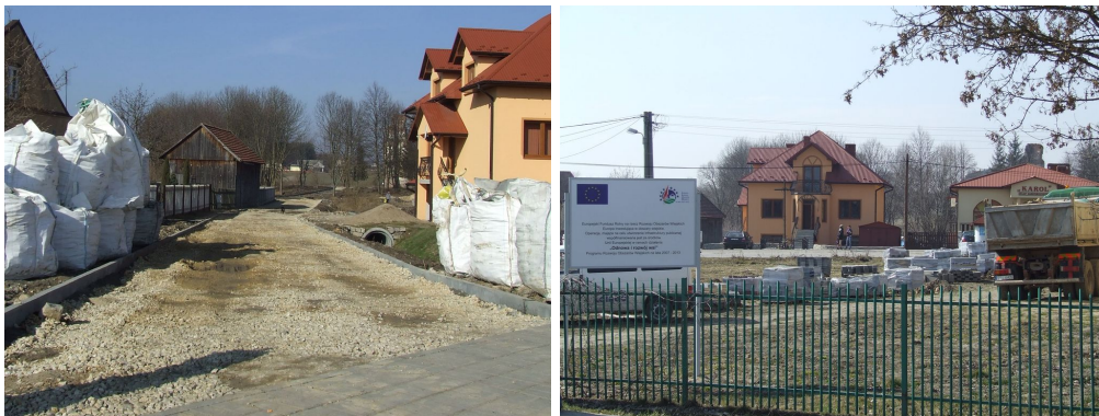
Remont alejki prowadzącej do ruin zamku oraz plac przy budynku UG w Rytwianach (po prawej)
