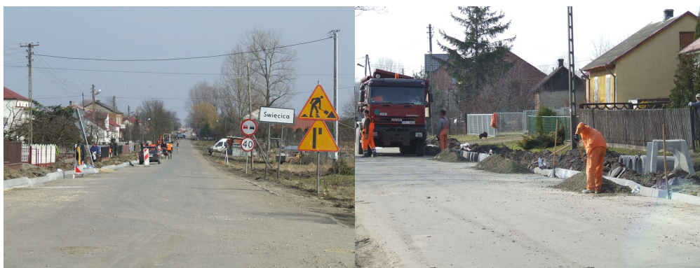
Remont drogi powiatowej, odcinek w Święcicy
