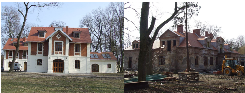
"Dom i Biblioteka Sichowska", widok na pensjonat (po lewej), remont budynku pałacu (po prawej)
