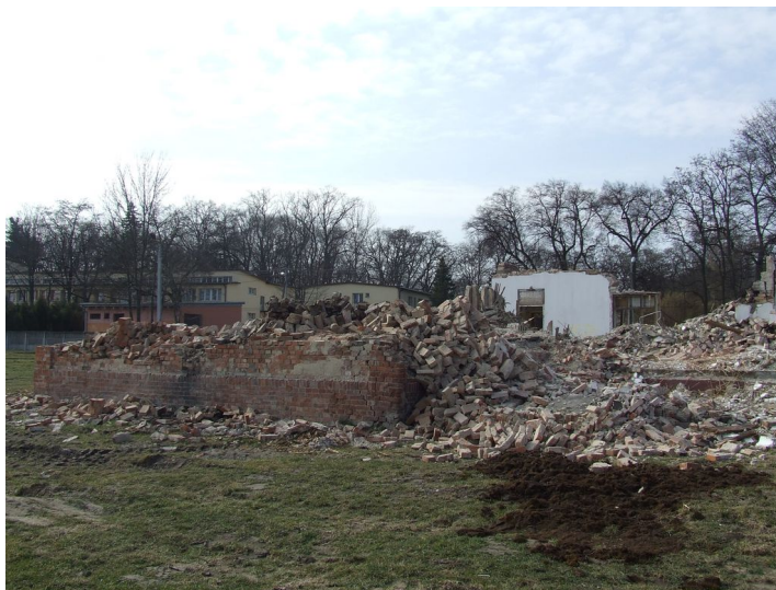
Rozbiórka budynku starej szkoły w Sichowie Dużym
