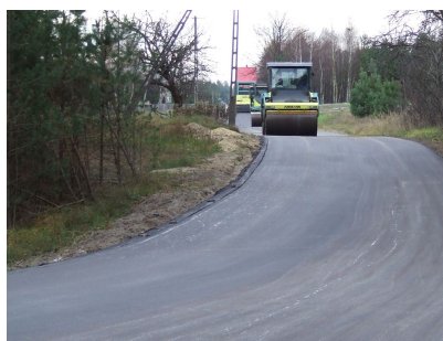
Droga w miejscowości Strzegom Kolonia
